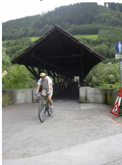
Ponte di legno
